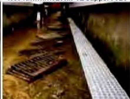
ตลาดสดบางกะปิ
